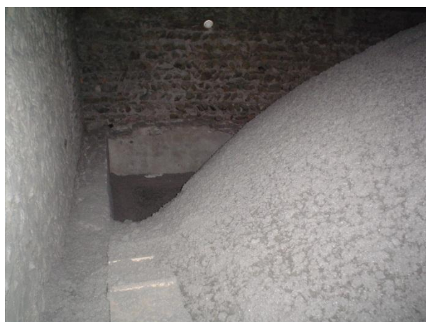
FOT. 2. Celuloza natryśnięta na sklepienie kolebkowe; fot.: DÄMMSTATT W.E.R.F. GMBH
