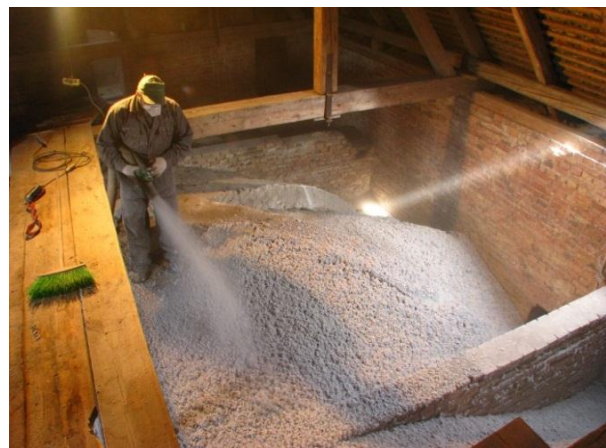
FOT. 8. Prace natryskowe na poddaszu kościoła w Górnio; fot.: S. ZIELIŃSKI
